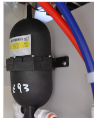
Fig. 7.2 - Vaso de expansão
