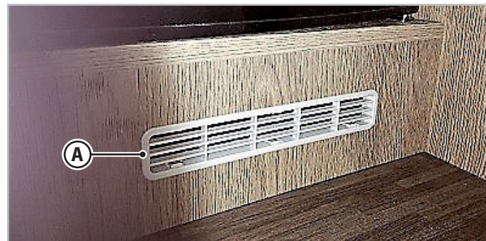
Fig. 6.1 - Aberturas de ventilação permanentes
