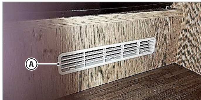
Rys. 6.1 - Stałe otwory wentylacyjne
