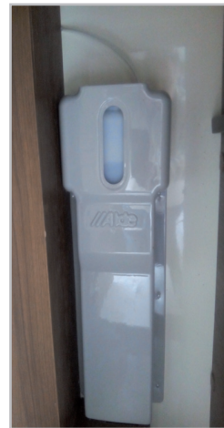
Afb. 6.48 - Glycolmengselniveau
