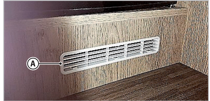
Afb. 6.1 - Permanente ventilatieopeningen
