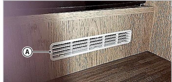
*Fig. 6.1 - Aberturas de ventilación permanentes*
