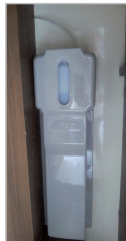
Εικ. 6.48 - Επίπεδο μείγματος γλυκόλης
