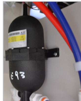
Fig. 7.2 - Vaso do espansione
